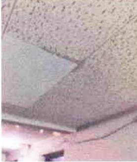
A 棟廊下での複数箇所でのひどい雨漏りがあり、火災報知器付近の雨漏りでは通電により報知機が作動してしまいました。
