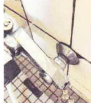
B 棟風呂場では蛇口付近から水漏れが起き、常時水が流れでる状態でした。
