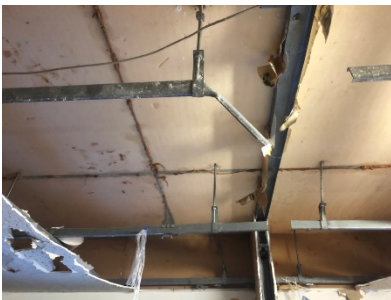
C 棟 5 階天井部分の損壊
