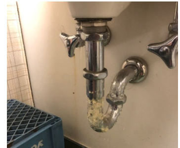
A 棟 2 階洗面台の水漏れ
