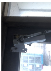
玄関ドアの破損
