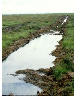
泥炭地排水路の浮上り
