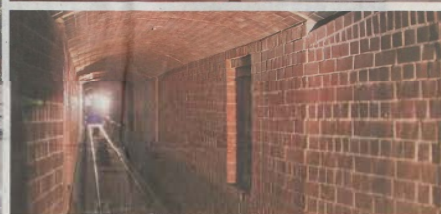
江別市元野幌にある米沢煉瓦の窯。長さは80m以上ある。1200度近い温度で焼いても形がほとんど変わらず、耐火性に優れた商品を生産できる野幌産煉瓦は「宝物です」と米沢昭二社長は言い切る
